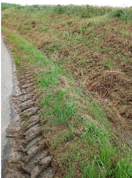
Figuur 14: Verstoorde berm – uitwijking van landbouwvoertuigen in de berm (Beeldekenstraat - berm32)
